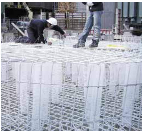
Fundamentbewehrung im Schalthaus der Peiner Träger GmbH, Peine, 2009
