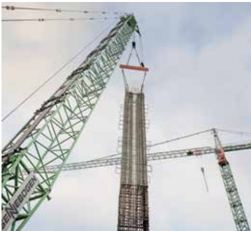
2. S-Bahn Stammstrecke, München, 2021 (©Moritz Bernouilly)
