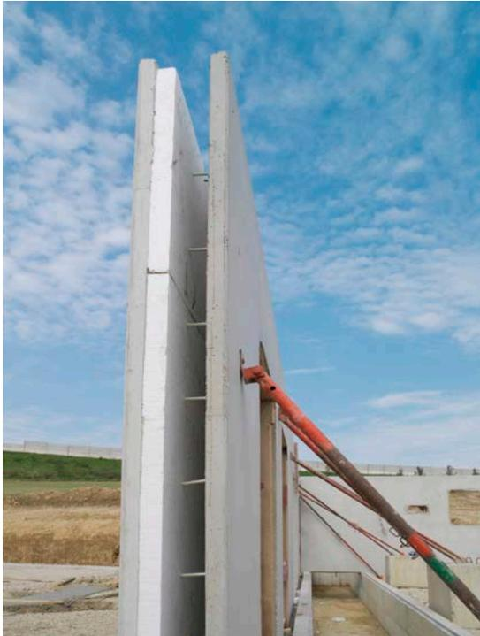
*Der Schöck Thermoanker ist vom DIBt Berlin für Sandwich- und Elementwände mit Innendämmung zugelassen und optimiert die Energiebilanz der Fertigteilwände.*
