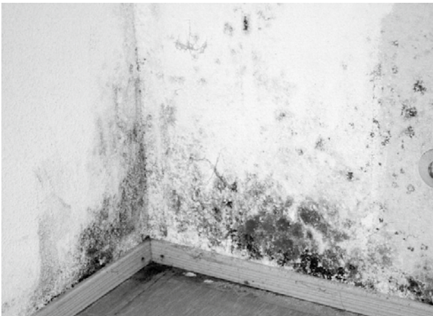
Beispiele für Schimmelpilzbefall im Wärmebrückenbereich.
